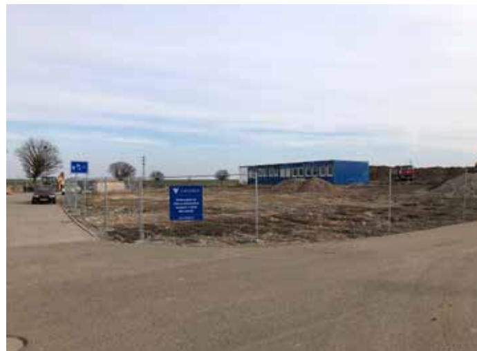
Stavební práce v Kovářské (únor 2018 / J. Hulík).
