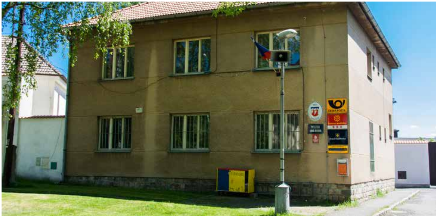
Budova obecního úřadu (červen 2017 / J. Hulík).
