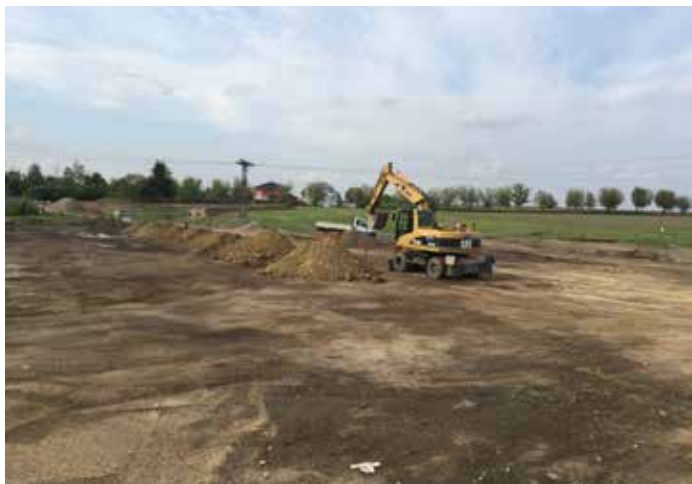
Staveniště etapy B vedle MŠ Jenštejn (J. Hulík / září 2017)
