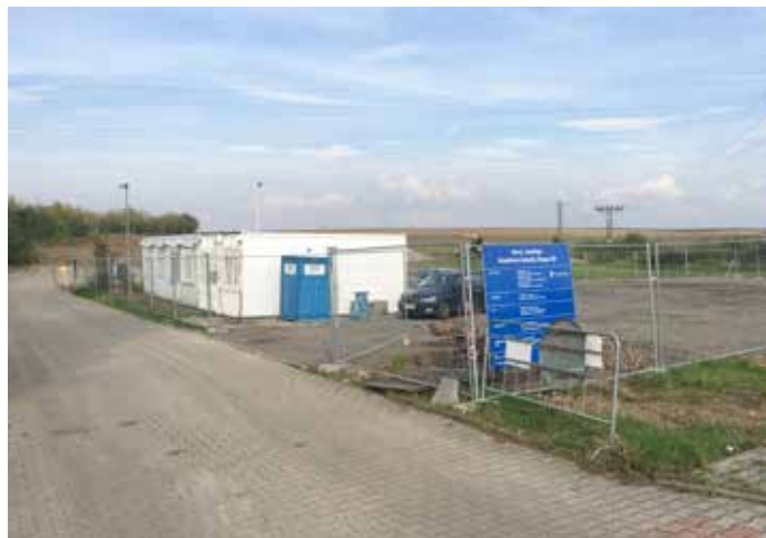
Zázemí staveniště etapy B (J. Hulík / září 2017)
