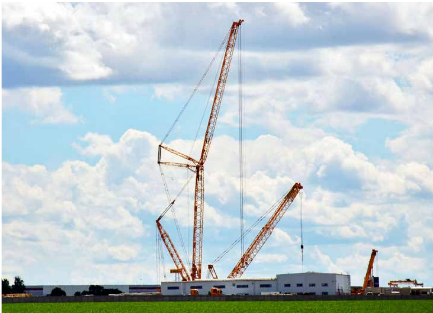
Jeřáb Liebherr LR 1750 v Radonicích
