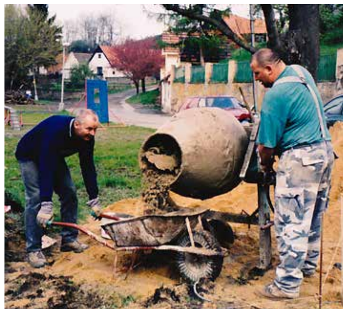
Výstavba nohejbalového hřiště 2006 (archiv V. Kovandý)
