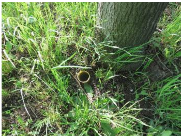
Špatné provedení závlahových sond
