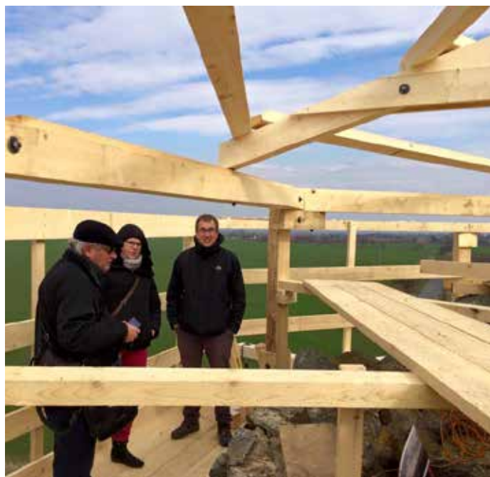
oprava hradu 2016 (obec Jenštejn / 2016)
