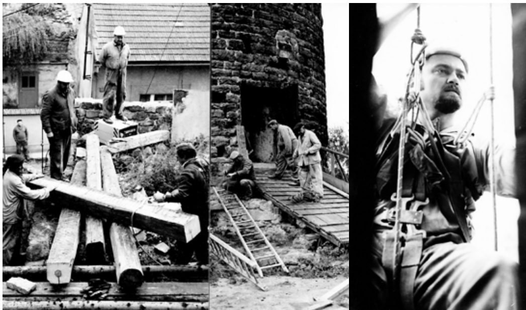
oprava hradu Jenštejn v letech 1973-1977 (archiv V. Kovandy)
